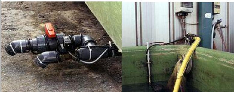
Нагревательные кабели PTFE Hemstedt® с различными сопротивлениями, поставляемые любыми длинами. Они используются, в частности, для защиты труб от замерзания. в химической промышленности, для монтажа в горячий асфальт, в сухих, влажных и мокрых помещениях, в трубах, в закрытых каналах, в штукатурке/под штукатуркой, в бесшовных полах и бетоне, на улице.
